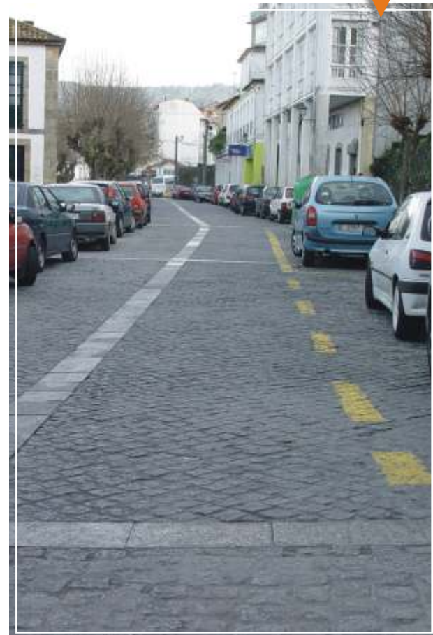
Aplicado como elemento estructural en calles de tráfico rodado.
