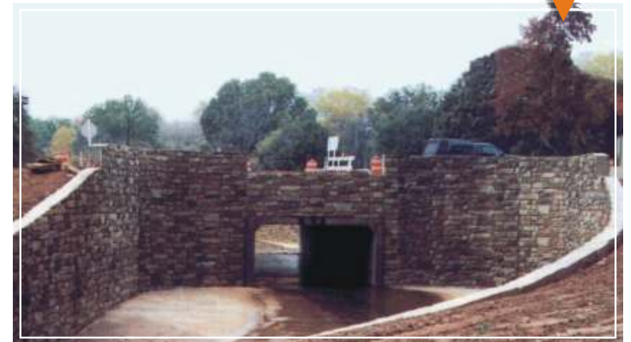
Aplicación sobre en puente para recubrimiento de instalación de tubería hidráulica. Modelo: TACO DE SANTIAGO
